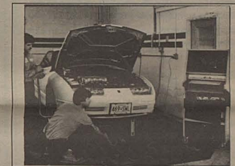
Le système «Shark» est un système complètement informatisé d'alignement de chassiss et de carrosserie une pièce.
